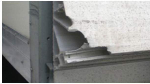
↻ Læssesmæk: Deformationer på platformen, som ikke kan betale sig at reparere, brudt eller ufuldstændig beklædning
