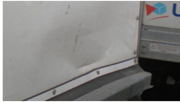
🔧 Side- og bagdøre: Betydelig deformation: Reparationstid > 1 t, kan betale sig at reparere, lukning ikke tætsluttende
