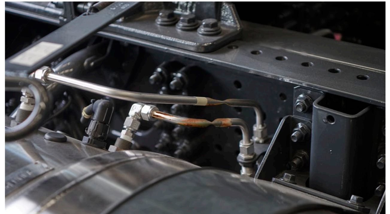
Rust, buler, brud og/eller udhulinger → gebyr for udskiftning af stive ledninger.
